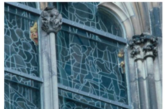
**Bild 11:** Köln, Dom, Außenansicht einer Schutzverglasung (Dombauhütte Köln)
