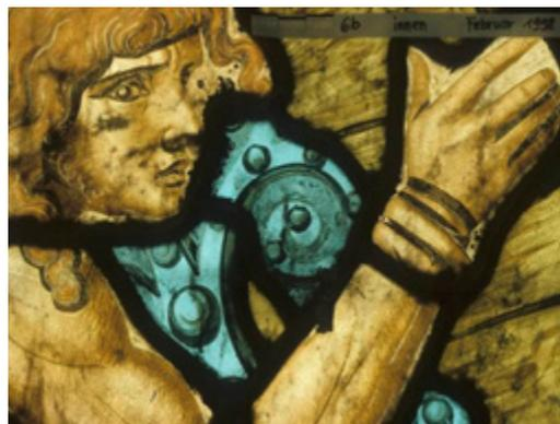
**Bild 13:** Köln, Dom, Detailvergrößerung „Samson mit den Stadttoren“. Kondenswasser hat Teile der zu niedrig eingebrannten Bemalung zerstört. (Dombauhütte Köln)
