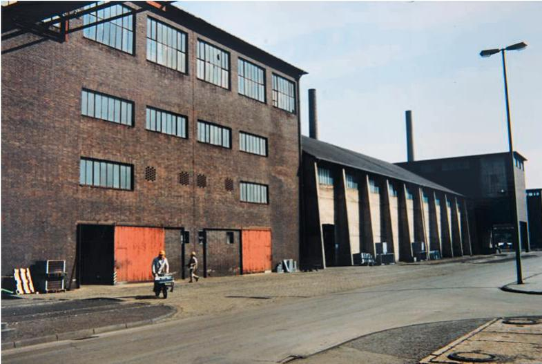
Salzfabrik, einem nicht unterkellerten Stahlbeton-Skelettbau mit 25 Zentimeter starkem, innenseitig verputztem Sichtklinker-Mauerwerk. Errichtet wurde er 1959 im Rahmen des von Fritz Schupp (1896–1974) geplanten Koke-reikomplexes, der 1961 seinen Betrieb aufnahm. Die Salzfabrik bildet den westlichen Anfang des Gebäudeensembles der Produktions-Linie Salzfabrik, Salzlager und Salzverladung (Bild 1).
