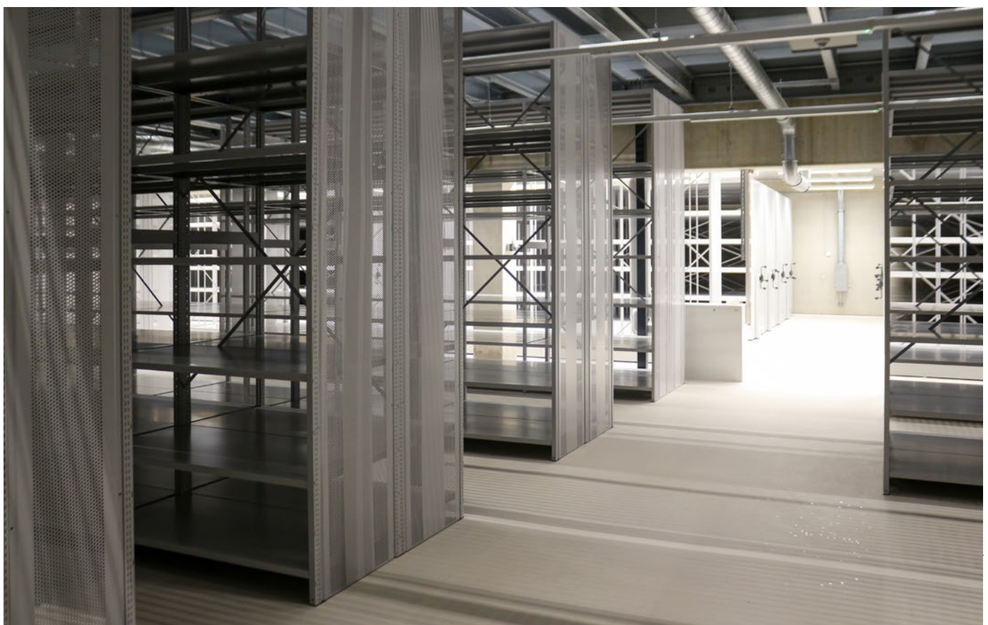
Bild 4 Regalanlagen auf emissionsarmem Epoxidharzboden
